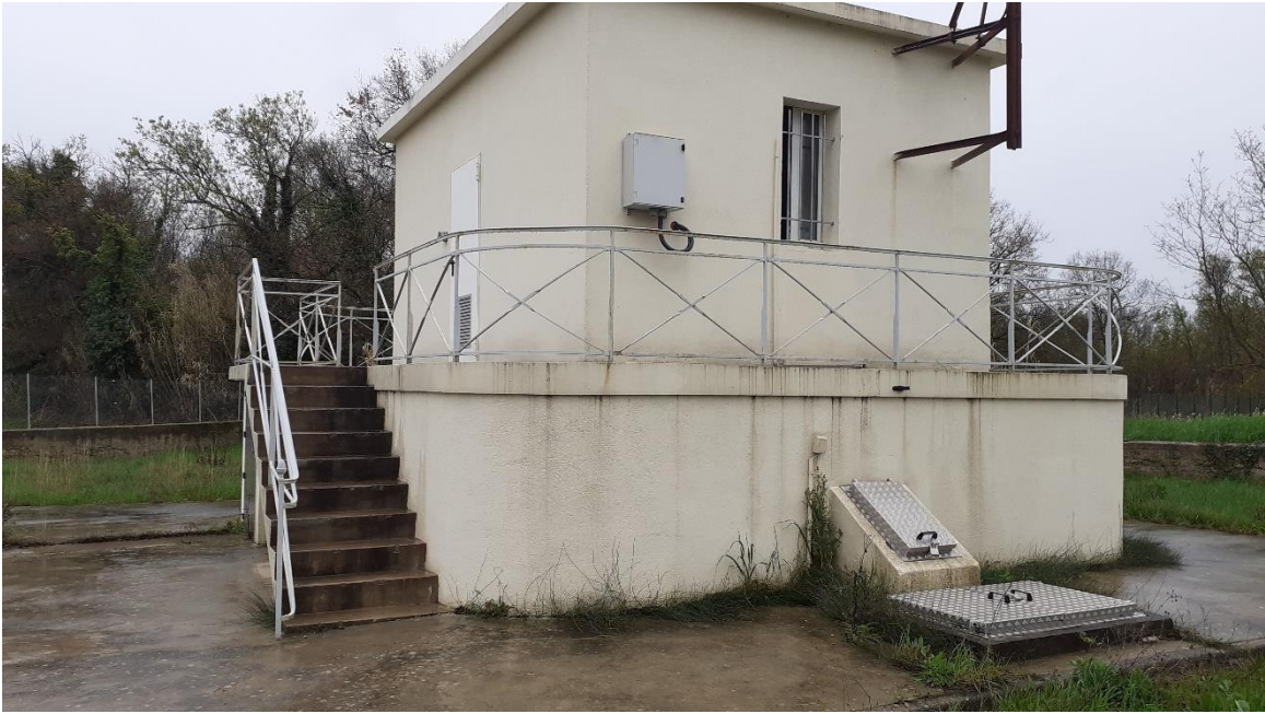
Local technique : exemple de protection contre les inondations [photo CE
