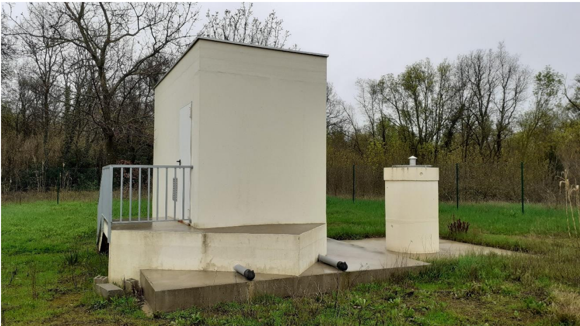
F 2017 : des renforts de protection contre les crues [photo CE
