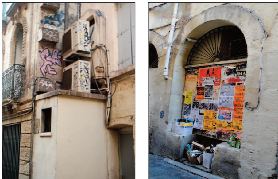
Espace public dégradé.
